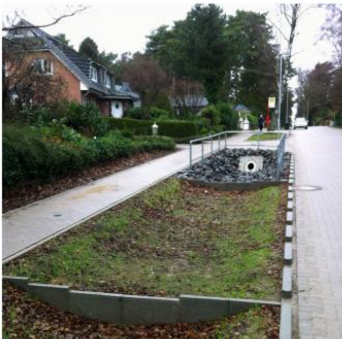
Figur 9-2. Svackdike med inloppsledning och dämmen. Foto: WRS
